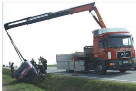
01.05.2013 PKW landet auf Dach - mit Kran geborgen
