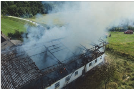
17.07.2013 15 Feuerwehren bei Brand eines Stallgebäudes in Schlagles
