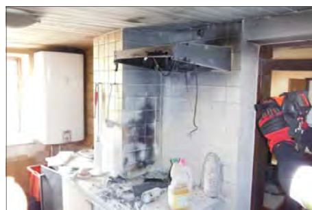
15.06.2014 Wärmebildkamera bei Küchen- brand in Puch im Einsatz
