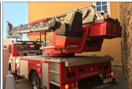
19.04.2018 Sicherungsarbeiten an der Stadtpfarrkirche
