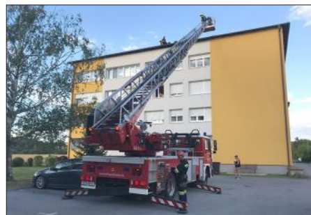
25.07.2018 Windböen reißen Dachlücke aus Verankerung
