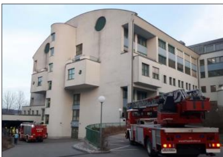
09.04.2018 Brandalarm im Müllraum des Landeskrankenhauses
