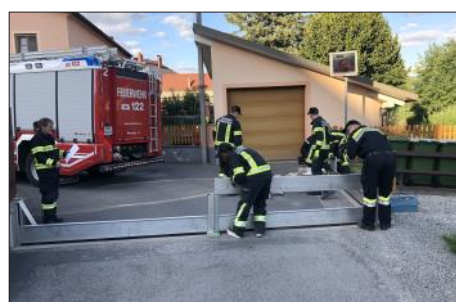
07.07.2020 Aufbau mobiler Hochwasser-schutz im Stadtgebiet
