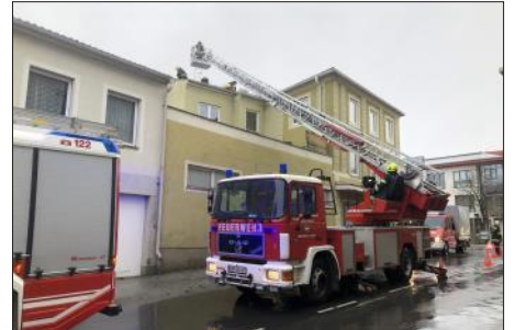
10.02.2020 Sturm reißt Blechdach aus Verankerung
