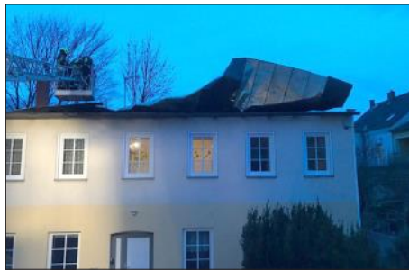
23.02.2020 Sicherung eines Blechdaches nach Sturmschaden
