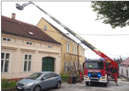
29.06.2022 Sicherungsarbeiten auf Dach nach Sturm
