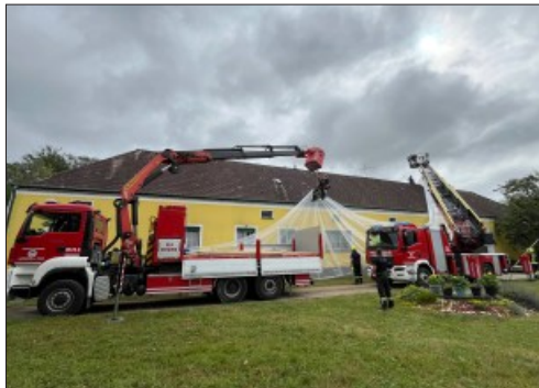
3-Tages-Einsatz mit Sonderfahrzeugen und Spezialkräften der Feuerwehr Waidhofen/Thaya
